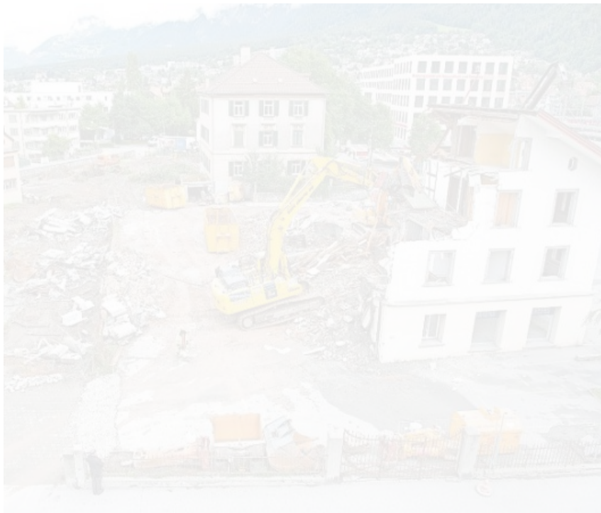
Platz für Neues: Die Abbrucharbeiten im Gebiet Titt beim Bahnhof Chur sind bereits weit fortgeschritten.
